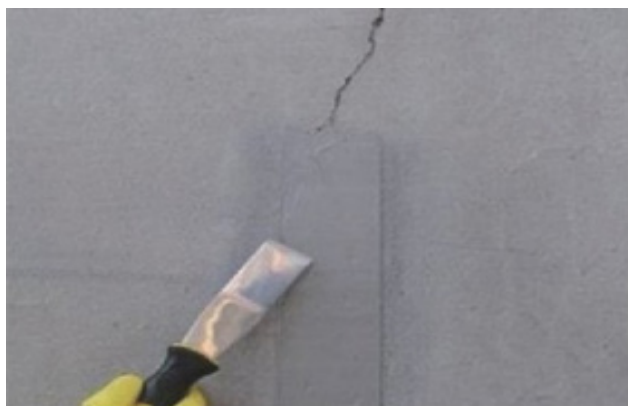
图1 裂缝填补法
