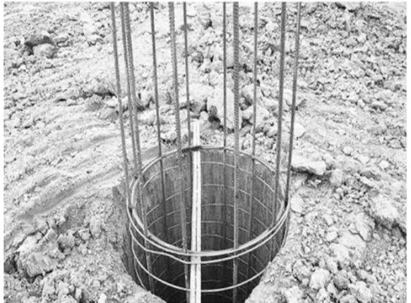
图1 钢筋笼安装
