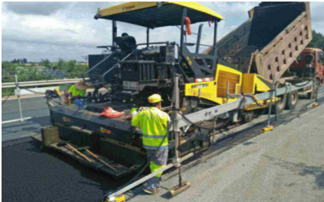
图1 沥青路面摊铺施工现场
