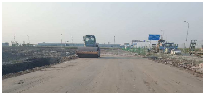
图1 市政道路路面硬化示意图
