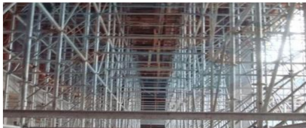
图1 高支模施工技术现场示意图
