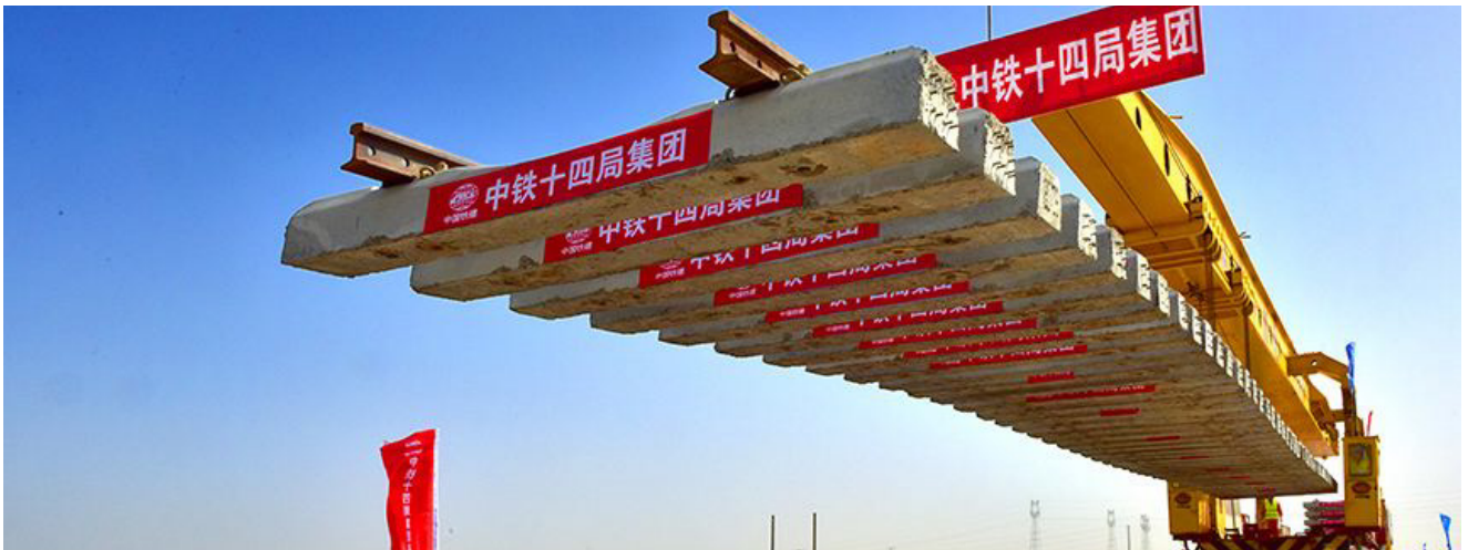
图3 轨排铺设现场照片
