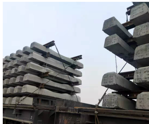
(b) 轨排现场加固照片
