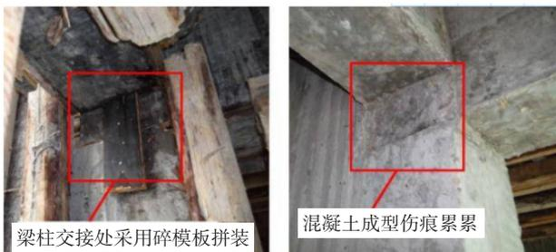
图1 建筑工程质量问题示例
