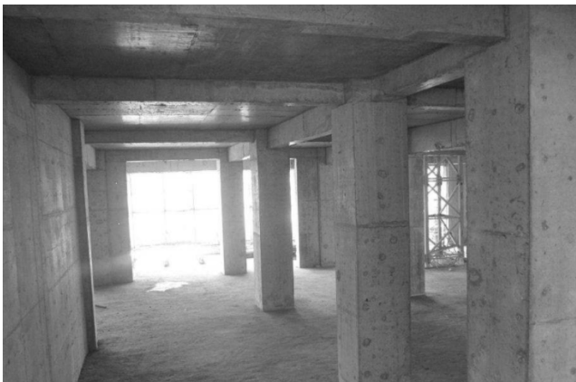
图3 底部框架剪力墙
