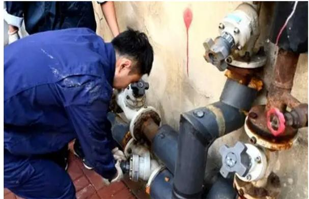
图3 热力供暖前冲洗试压
