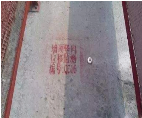
图1 基坑变形监测中常见的监测点类型
