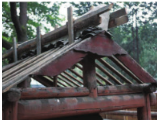
图1 对屋脊采用木条夹护
