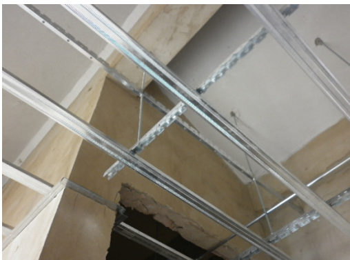
图1 安装吊筋
