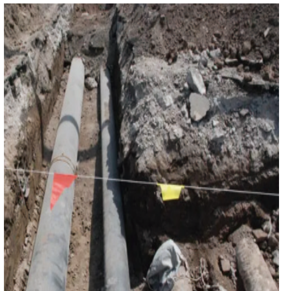
图3 市政工程地下管线施工
