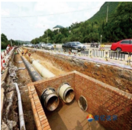
图1 市政工程地下管道敷设
