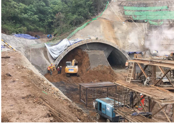
图5 隧道浅埋偏压段双侧壁导坑法施工
