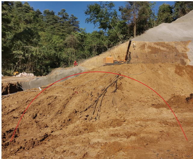
图3 隧道出口右线洞口气貌
