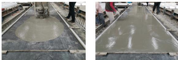
图2 UHPC薄板浇筑
