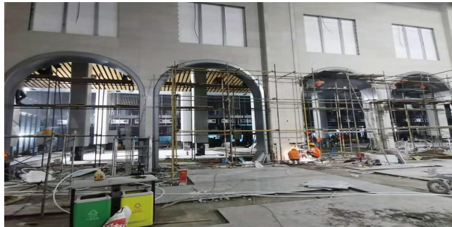
图2 候车厅改造中
