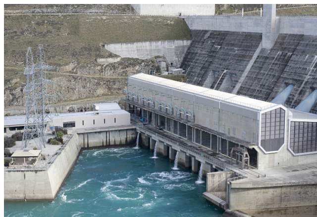
图1 水利工程建设实况
