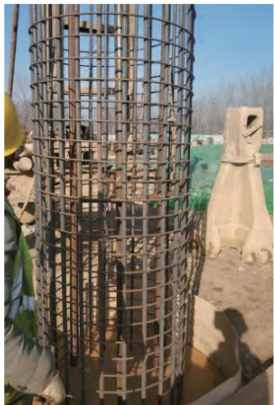
图2 钢筋笼的安放
