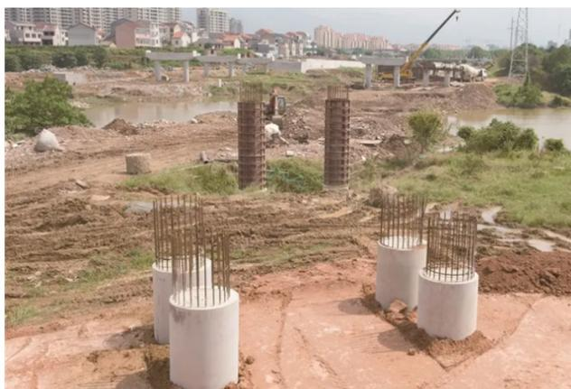
图1 桩基施工图
