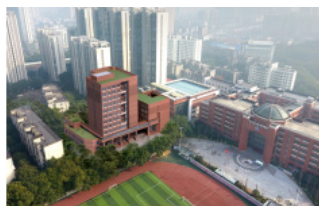
综合楼立体屋顶花园
